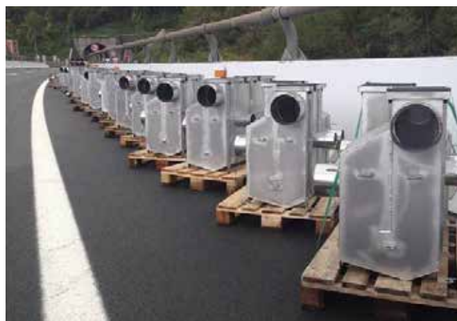
Pozzetti tagliafiamma in acciaio inox installati nella galleria del Cucchero
